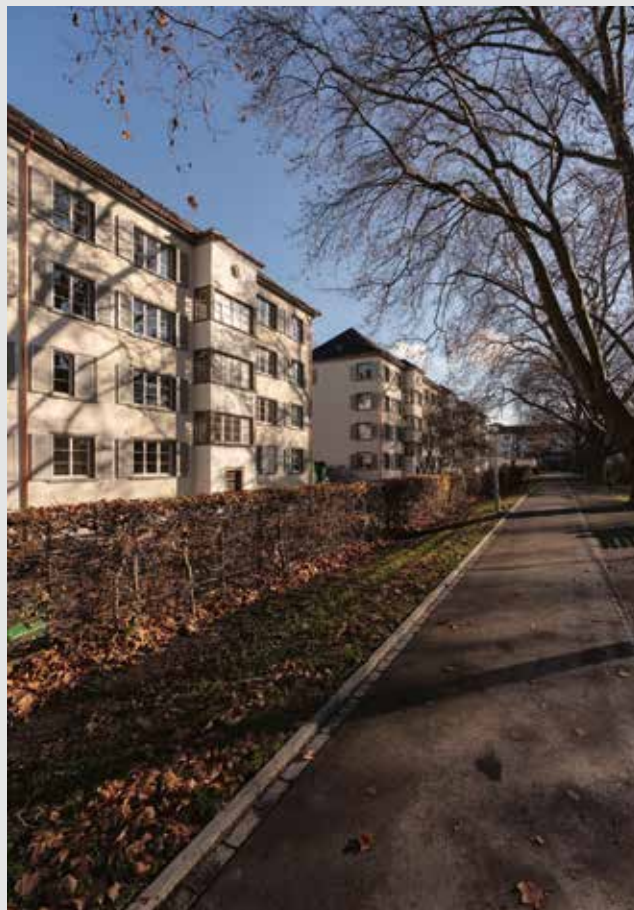
Le Bullingerhof, le plus grand ensemble de blocs en bordure d'îlots de la ville de Zurich, est classé monument historique. C'est pourquoi la rénovation complète actuelle de la cité nécessitait des solutions spéciales, y compris pour la couleur des façades. Une mission pour Karl Bubenhofer SA
