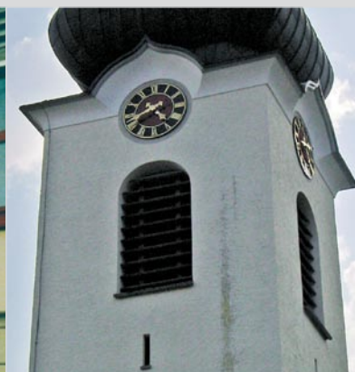
Kupferflecken an Fassaden
